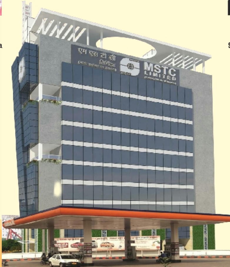
न्यू टाउन, कोलकाता में एमएसटीसी का निर्माणाधीन निगमित कार्यालय MSTC's proposed Corporate Office Building being constructed at New Town, Kolkata
